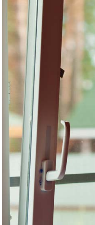
Lüftung durch Kippstellung
